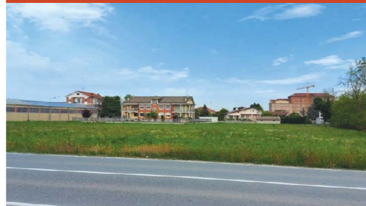
Il terreno acquisito dal Comune per la realizzazione della nuova scuola secondaria di primo grado.
